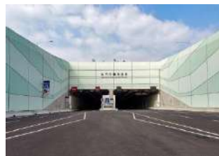
屯门-赤鱲角隧道
